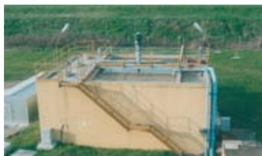
Foto 4 Chiariflocculatore o Sedimentatore
