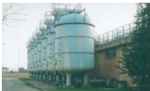
Foto 7 Batteria filtri a carbone
