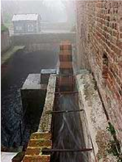
Figura 54 - Mulino "per di sotto"
